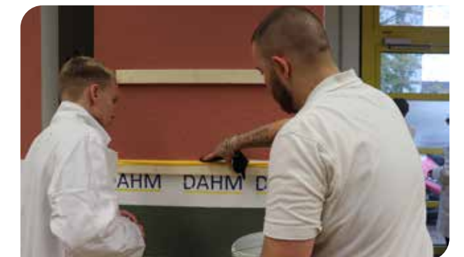
Handwerk ganz konkret: Azubi Kacper Kalolak zeigt das korrekte Abkleben
